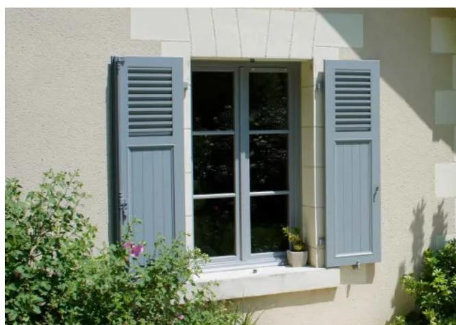
Klappläden mit feststehenden Lamellen bestehen aus mindestens einem Feld mit feststehenden Lamellen. Unabhängig davon können weitere Felder mit Aluplatten (glatt, längs- oder quergerillt) geschlossen sein. Zwei oder mehr Felder werden durch einen Längs- oder Querfries getrennt.
