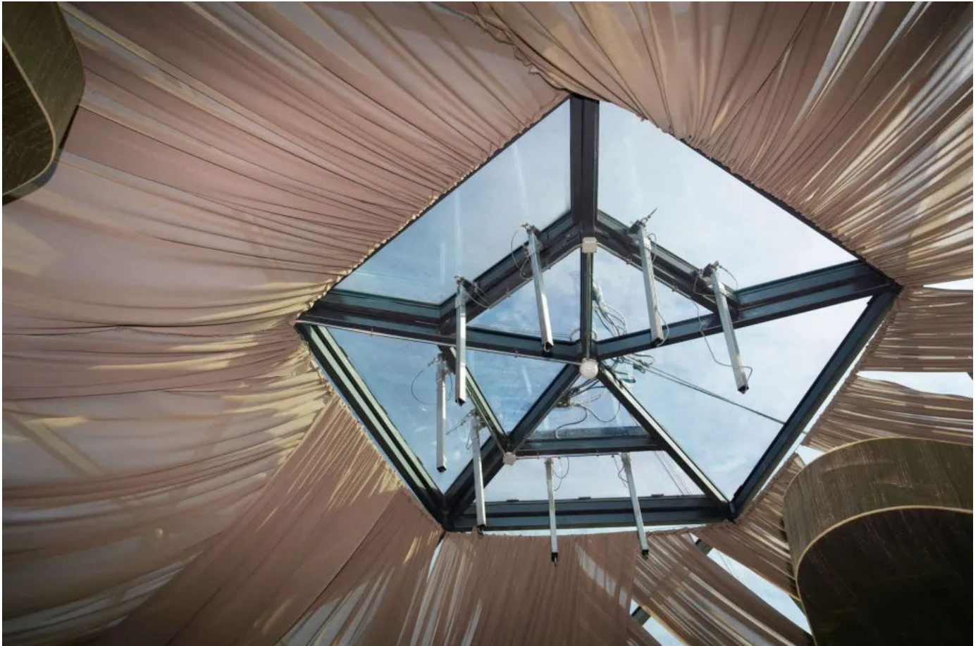
E350 N – Spindelantrieb in 230 V-Ausführung mit umfangreichem Konsolenprogramm, © GEZE GmbH
