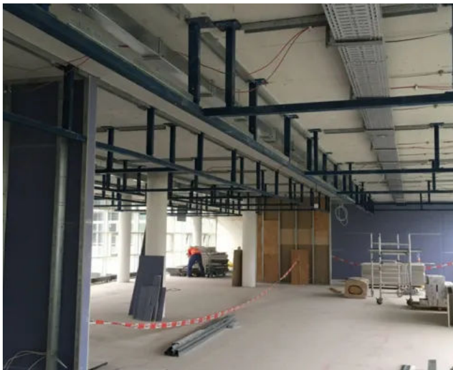
Abschottung FA-DI - Deckenschürzensysteme für Installationen
