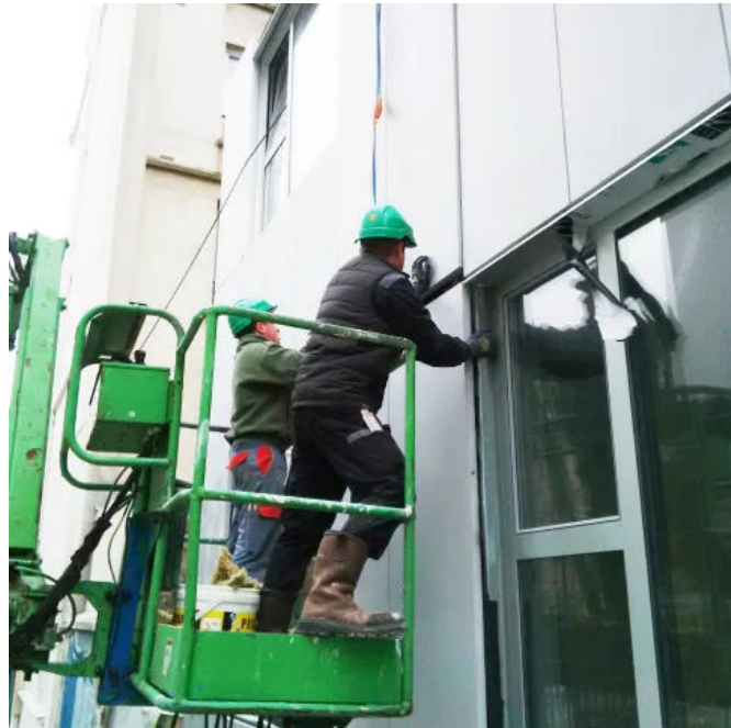
FClad® Fassadenplatten werden an der Bestandsfassade befestigt.
