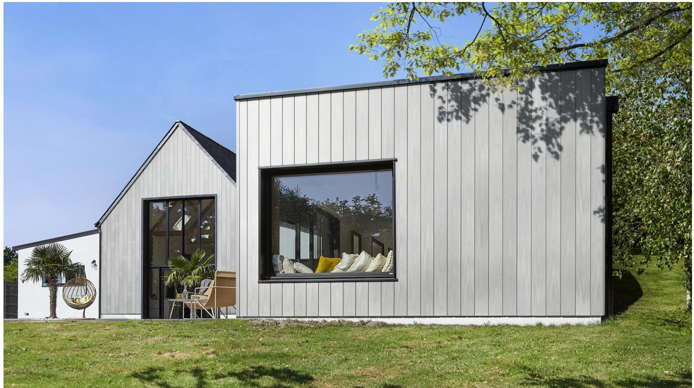
Die Rhombus-Fassadenverkleidung Atmosphere wird im Co-Extrusion-Herstellungsverfahren gefertigt. Dabei wird jede einzelne Diele mit einer schützenden Schicht aus Polymer ummantelt. Die ebenfalls co-extrudierte Fassadenverkleidungsleiste Atmosphere 175 ergänzt das Sortiment für die Fassadenverkleidung und bietet noch mehr Auswahl.
