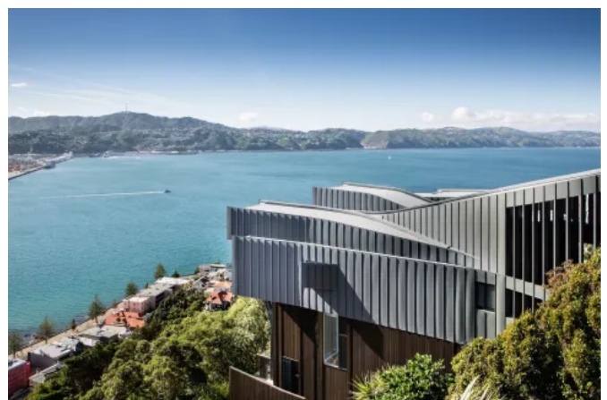
Zinc House - Wohnhaus, Waikanae, Neuseeland | PARSONSONS architects ltd., Wellington, Neuseeland
