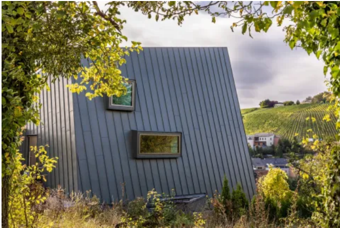
Wohnhaus, Wormeldingen-Ehnen, Luxemburg | bureau d'architecture WeB s.à.r.l., Grevenmacher, Luxemburg
