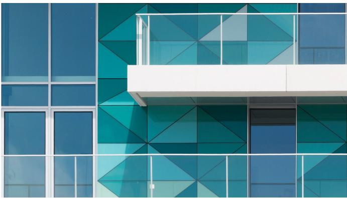
StoVentec Glass - Exklusive hinterlüftete Fassaden mit großformatigen Glaspaneelen und StoVentec G - Glasplatten für individuelle Fassadenbilder auf hinterlüfteten Fassaden
