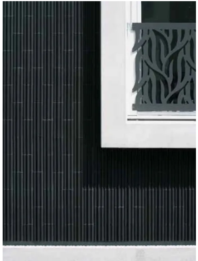
Materialübergang vom Sockel und Fenster zur Keramikfassade
