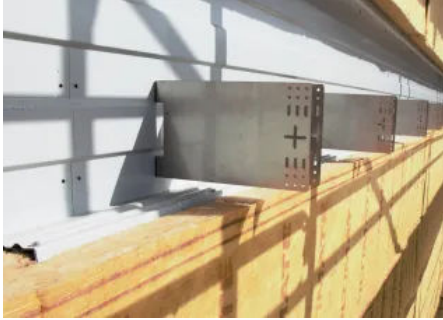
PRO+ Unterkonstruktion Wandkonsolen U-Halter
