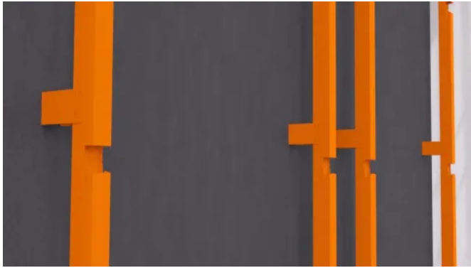
04a Modulrohre der Fassadenunterkonstruktion
