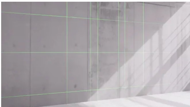
01 Laserprojizierte Markierungen
