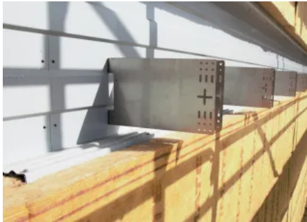
PRO+ Unterkonstruktion Wandkonsolen U-Halter
