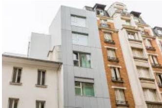
FClad® Fassadensanierung - Pflegeheim in Paris
