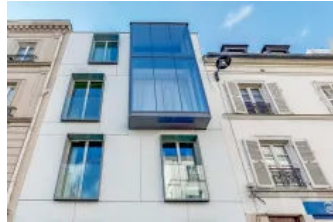
FClad® Fassadensanierung - Wohnungen in Paris
