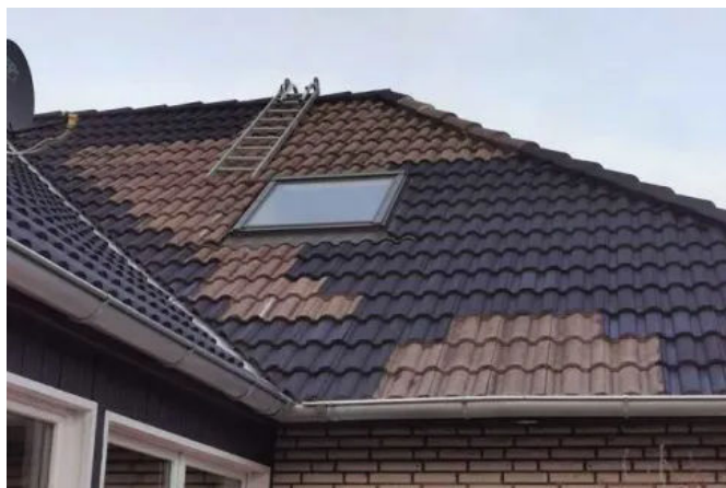
Überarbeitungsanstrich mit Color PA Roof
