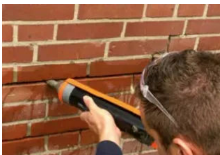
Rissinstandsetzung mit dem Remmers Spezialanker-System (© Remmers)
