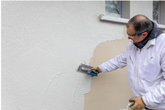
Noblo 600 Sprint ist ein schnell überarbeitbarer Scheibenputz mit Marmorkorn.
