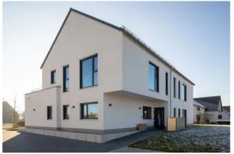
Mit dem Fassadenputz-System SM600 Sprint und Noblo 600 Sprint kann die Folgebeschichtung bereits am nächsten Tag ausgeführt werden.
