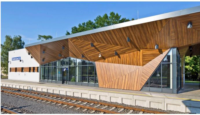
m.look, die brandbeständige Fassadenplatte mit HPL-Oberfläche und Zulassung als Bekleidung für vorgehängte hinterlüftete Fassaden, kann selbst an Hochhäusern von über 20 Meter eingesetzt werden.
