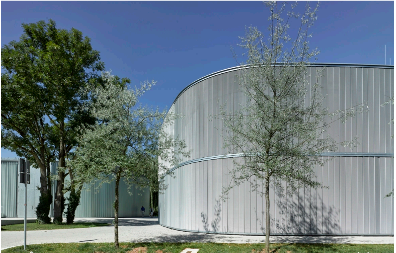
Pfosten-Riegel-Fassade aus Stahl und Glas, vorgehängte Streckmetall-Fassade, Glasdach (© Peter Oppenländer)
