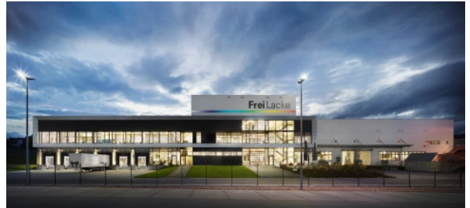
Pfosten-Riegel-Fassade aus Stahl und Glas, Aluminium-Elemente innen, Glasdach, Lacker Lamellenfenster bigAir® Fassade (© Steffen Schrägl)
