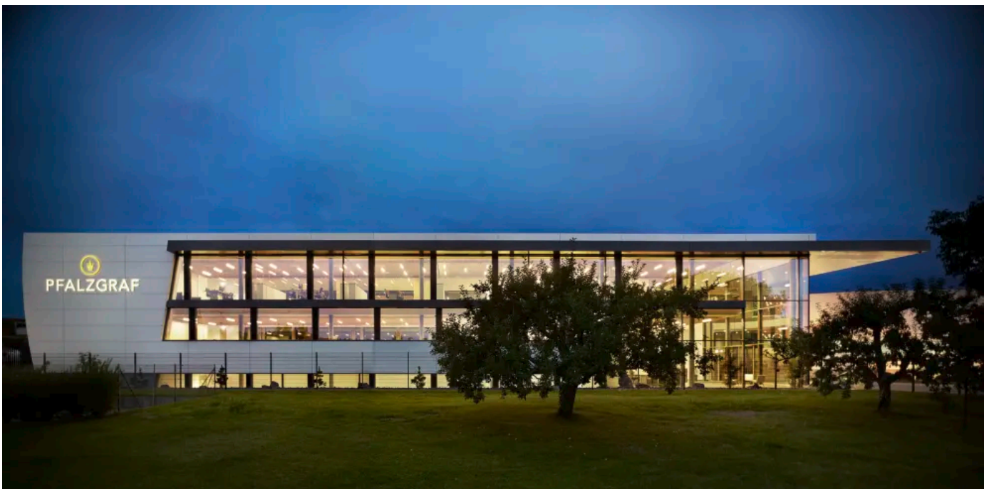
Teilweise gebogene Pfosten-Riegel-Fassade aus Stahl, Aluminium und Glas, Lacker Lamellenfenster bigAir® Fassade und Drehfenster bigSwing (© Steffen Schrägl)
