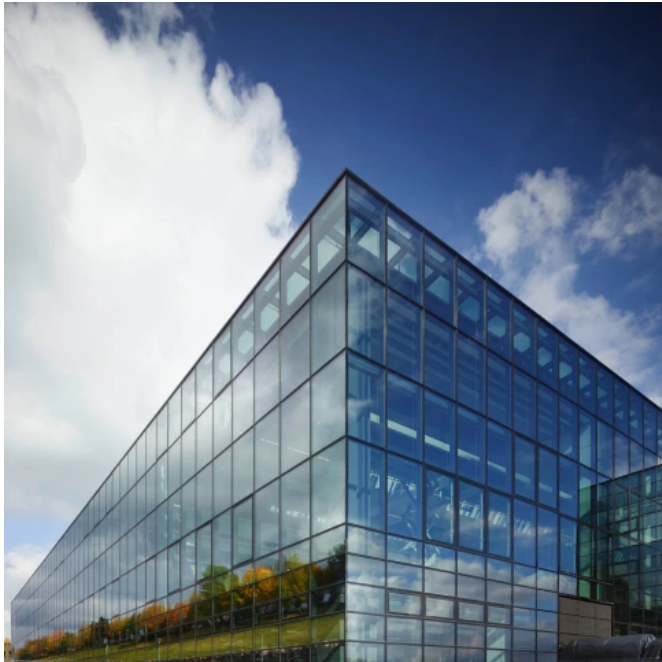
Beheizte Pfosten-Riegel-Fassade aus Stahl und Glas, Glasdach, Lacker Klapp- und Drehfenster bigSwing (© Steffen Schrägele)
