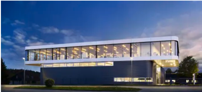
Teilweise gebogene Pfosten-Riegel-Fassade aus Stahl und Glas und teilweise gebogene scharfkantige Blechverkleidung (© Steffen Schrägl)
