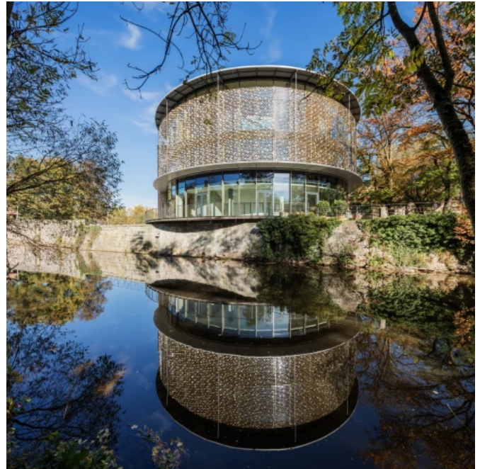
Blechverkleidung aus Aluminium, Lacker Lamellenfenster bigAir® Fassade (© Dirk Altenkirch)
