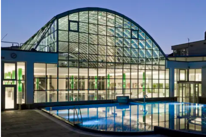
Seilunterspanntes Glasdach, Foto: Gericke Gestalter
