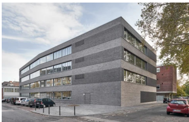
Köln, Humboldt Gymnasium
