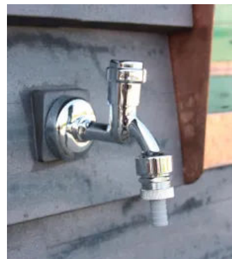
Anschluss Wasserhahn
