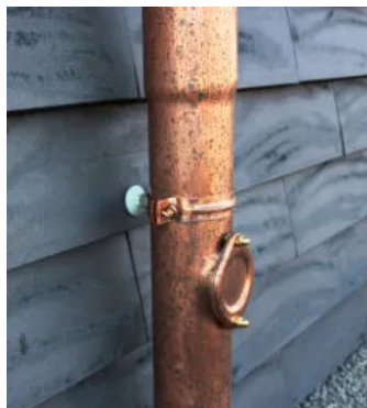
Befestigung von Fallrohren
