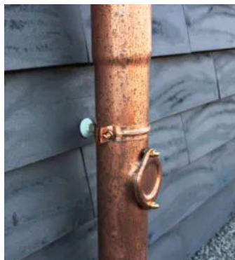
Befestigung von Fallrohren
