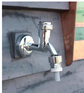
Anschluss Wasserhahn
