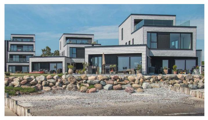
VERTICO Fassadenplatten werden sowohl zur vollflächigen Fassadenbekleidung, als Dacheindeckung und zur gezielten Akzentuierung von Gebäudeteilen wie Eingangsbereichen eingesetzt. Die keramischen Platten eignen sich besonders für Projekte mit hohen Anforderungen an Langlebigkeit, Brandschutz, Nachhaltigkeit und gestalterische Flexibilität.
