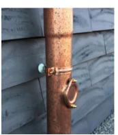
Befestigung von Fallrohren
