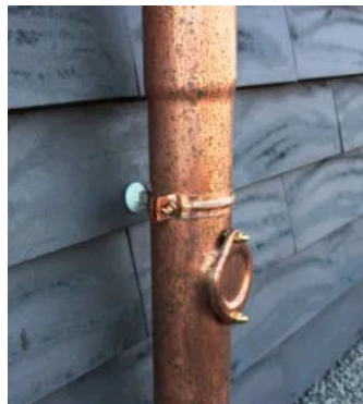
Befestigung von Fallrohren
