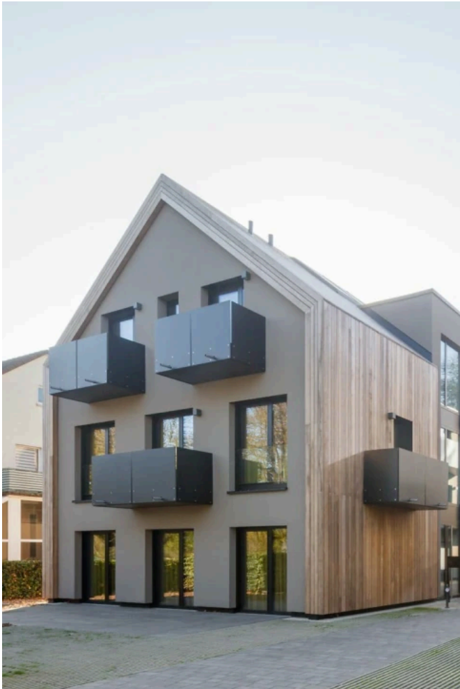
Studentenlofts am Schwanenteich, Gießen - Planung: Kai Laumann Zimmerei- und Bedachung GmbH | Foto: Caparol
