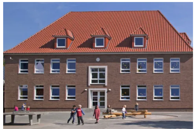
Grundschule, Oytten - Planung: Kay Böning | Fotos: Caparol Farben Lacke Bautenschutz / Martin Duckek
