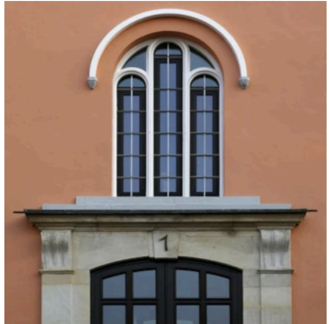
Rathaus Hofgeismar - Planung: Bauamt Stadt Hofgeismar | Foto: Caparol
