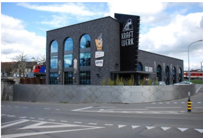
Bürogebäude „KRAFTWERK“, Wil - Planung: Architekt Roger Edelmann | Foto: Arson AG
