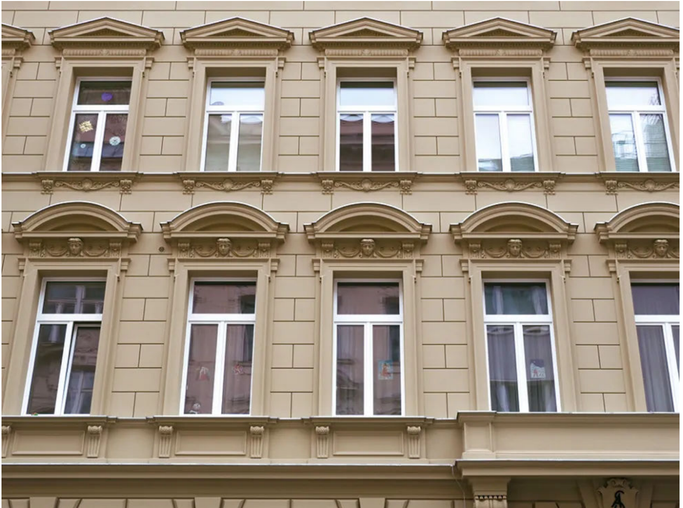
Nach der Sanierung mit Austrotherm Fensterumrahmungen
