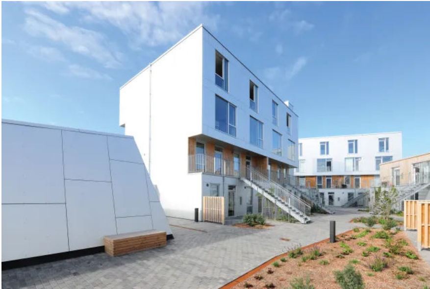
Den nachhaltigen Charakter des Quartiers unterstützt auch die Bauweise der Wohngebäude, die aus vorgefertigten Holzmodulen montiert wurden.
