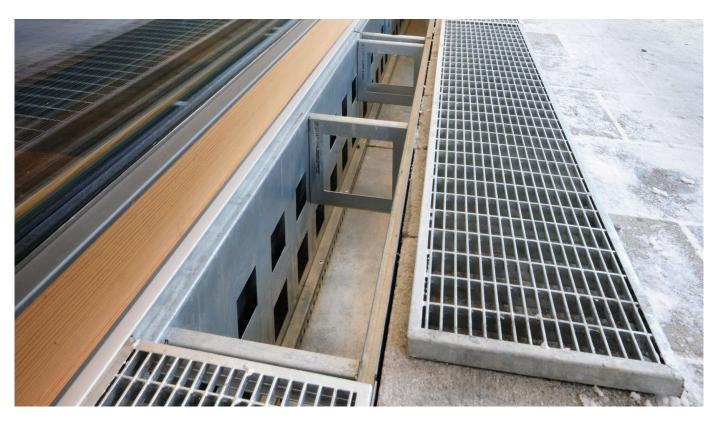
Fassadenentwässerungsrinnen von Richard Brink bieten für jede Einbausituation und in individuellen Abmessungen die perfekte Lösung. Sie leiten nicht nur Regenwasser ab, sondern sorgen mitunter für eine dauerhafte Belüftung und Trocknung des Sockelbereichs.
