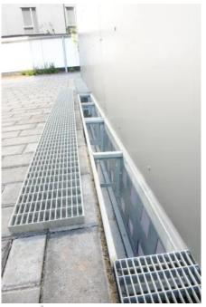
Großflächige Öffnungen am fassadenseitigen Bereich der Rinne und der ebenso weit hervorstehende Rinnensockel sorgen für ausreichenden Abstand zur Fassade und einen gut durchlüfteten Wandanschluss.
