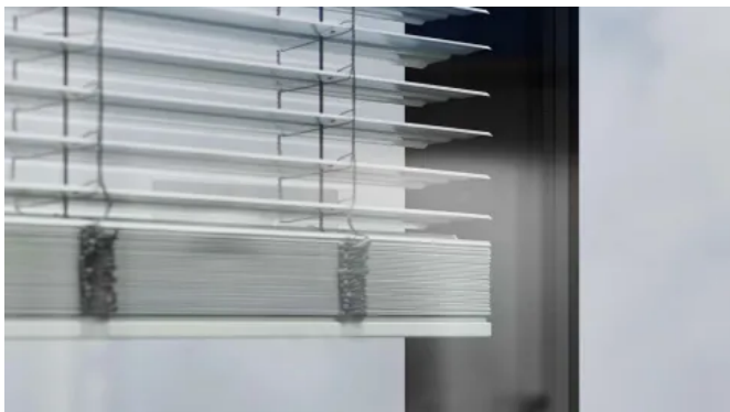
Raffstores mit Lichtlenklammeln sorgen für optimalen Lichteintrag. (© BECKER LACOUR / Olaf Becker)
