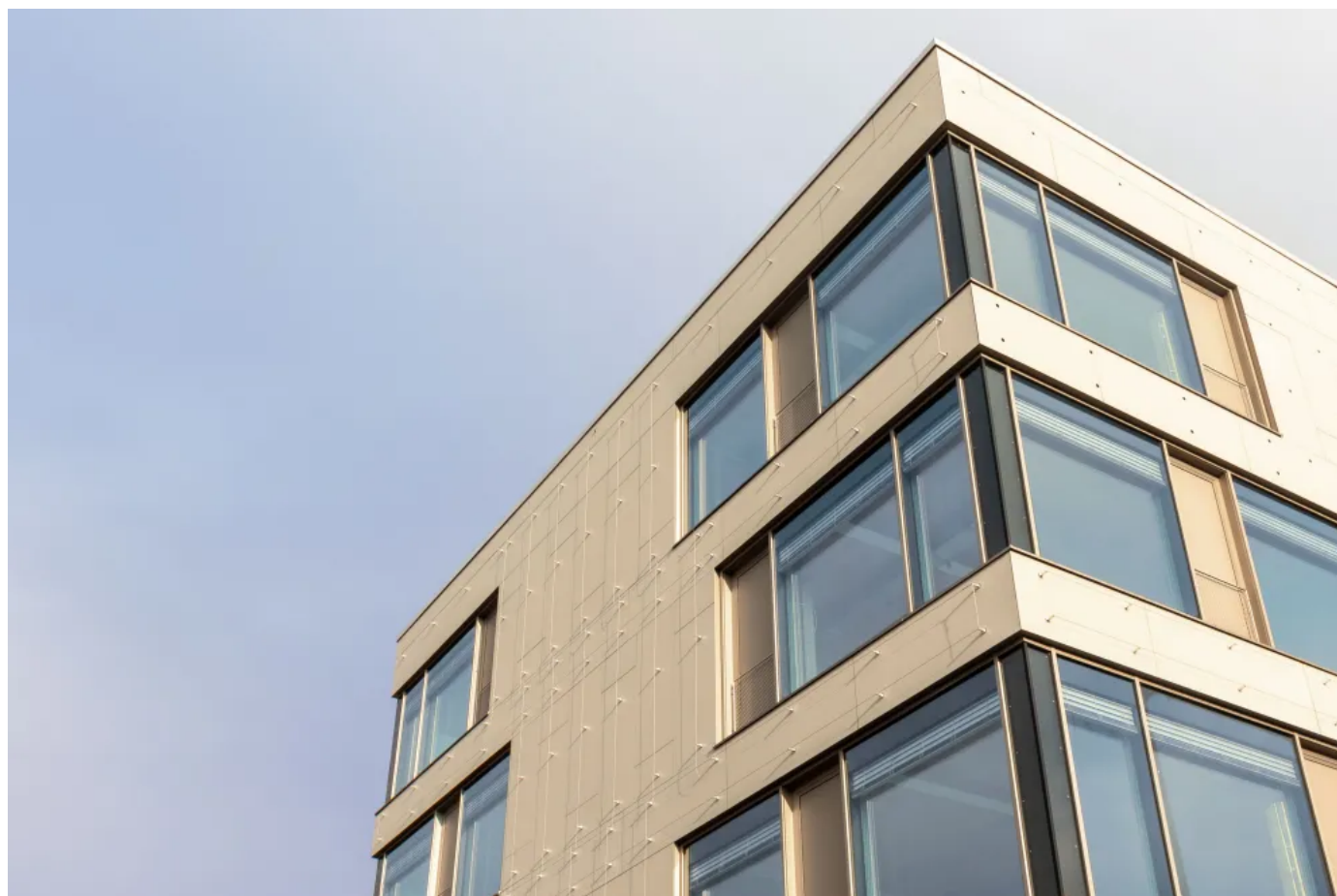
In Verbindung mit der geplanten Fassadenbegrünung entsteht eine intelligente Lösung: Der Sonnenschutz liegt geschützt im Zwischenraum. (© JONAS Architectes)
