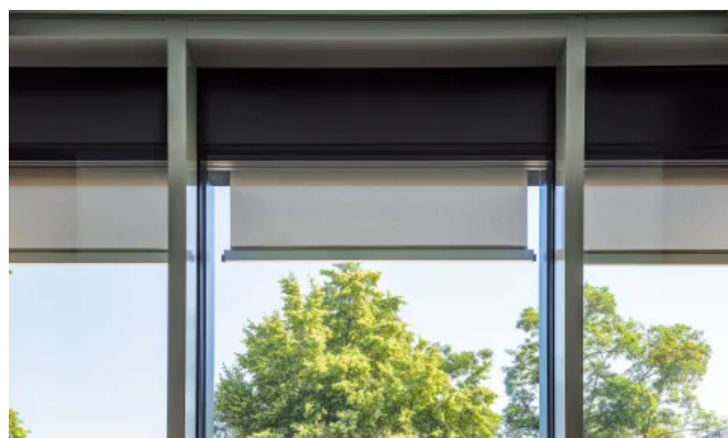
Die Fassadenelemente wurden mit einer integrierten Senkrechtmarkise ausgeführt. (© Till Schuster)
