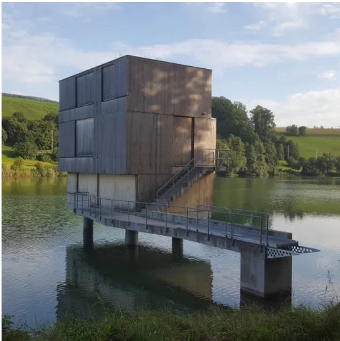
Accoya®-Holzfassade: Zielturm im Ruderzentrum der Naturarena Rotse, Schweiz
