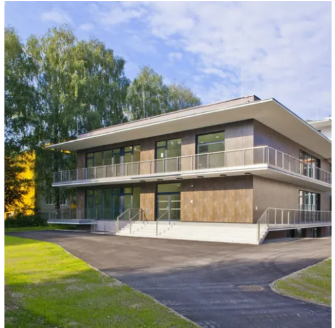
Schule Liefering, Österreich Architekt DI. Johannes Schallhammer m.look Exterior | A2-Qualität NT, Dekor 0792 Patina Graubraun
