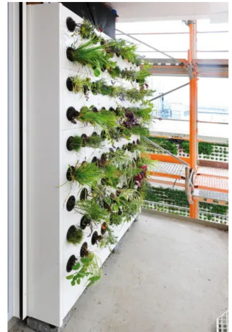
Vorgehängte, hinterlüftete Pflanzkassetten wurden mithilfe von Trägerschienen an der Fassade befestigt. ©Richard Brink & Co. KG
