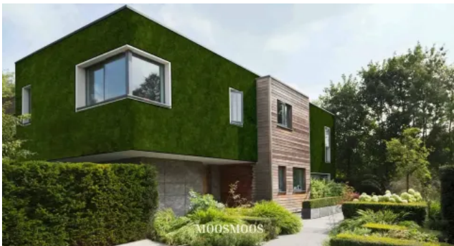
MOOSMOOS Greenovation, Einfamilienhaus - Fassadenbegrünungen (© MOOSMOOS)
