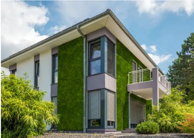
Moosfassaden - Fassadenbegrünungen (© Alexander & Theresia Schulz)
