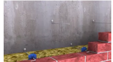
MOSO® HV-L Luftschichtösenanker für die nachträgliche Befestigung
