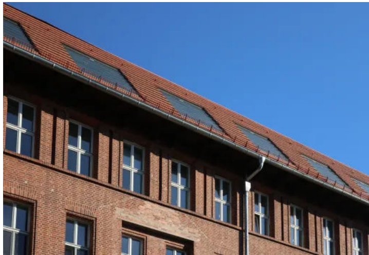
Als zertifizierte NRW-Elemente nach DIN EN 12101-2 erfüllen die bigAir® Dachfenster höchste Sicherheitsstandards im Brandschutz. © LACKER GmbH
