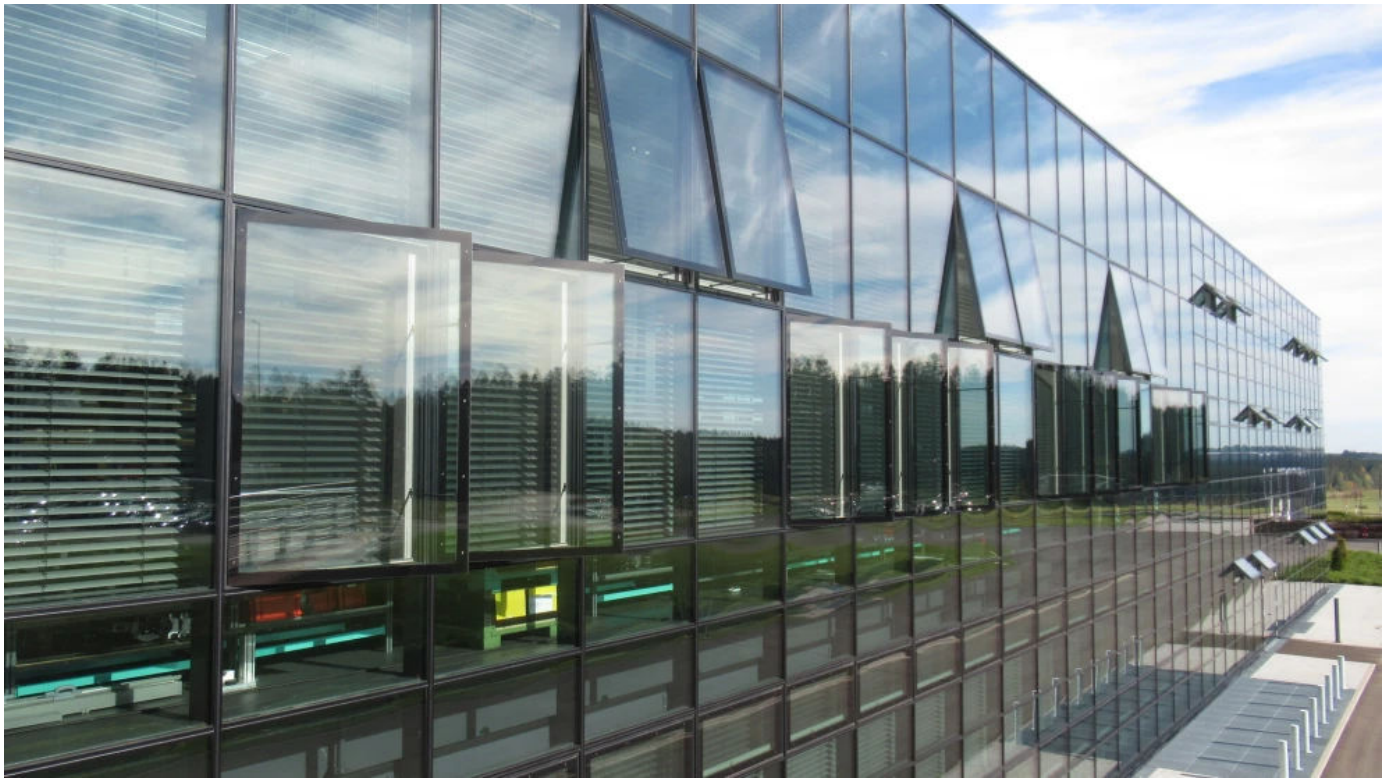
Große bigSwing Klapp- und Drehfenster mit 3-fach Sonnenschutzverglasung in einer SG Fassade.
