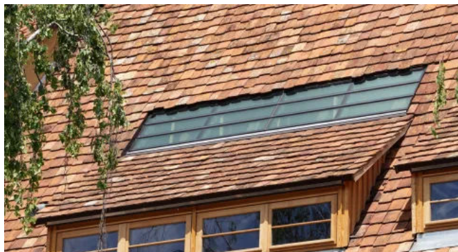
3-Fach-Sonnenschutzverglasung und Insektenschutzgitter ©LACKER GmbH
