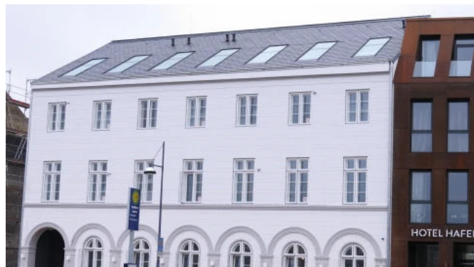
Objektbeispiel: 2-teilige topSwing Fenster, die flächenbündig in ein Schieferdach eingebaut wurden. Nutzung auch als Ausstiegfenster möglich.
