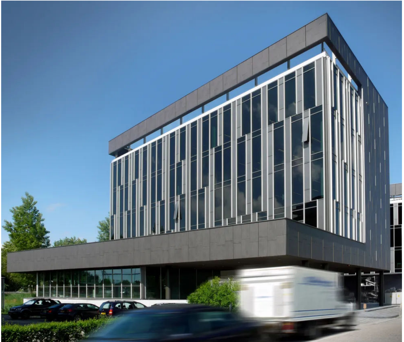
Gouwezone – Bürogebäude mit hinterlüfteter Mosa Fassade und sichtbarer Klammerbefestigung.
