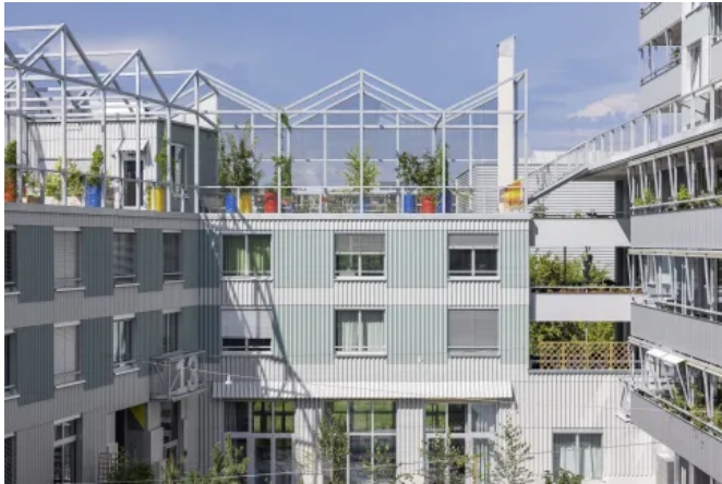
Wohnanlage im Westhof
