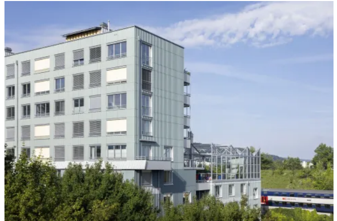
Wohnanlage im Westhof
