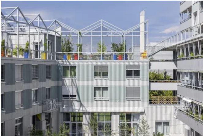
Wohnanlage im Westhof
