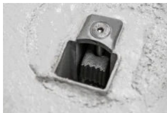
Einbetonierte Bodenhülse
