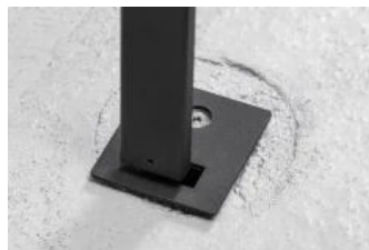
Fahrradparker einstellen und Verschraubung festziehen
