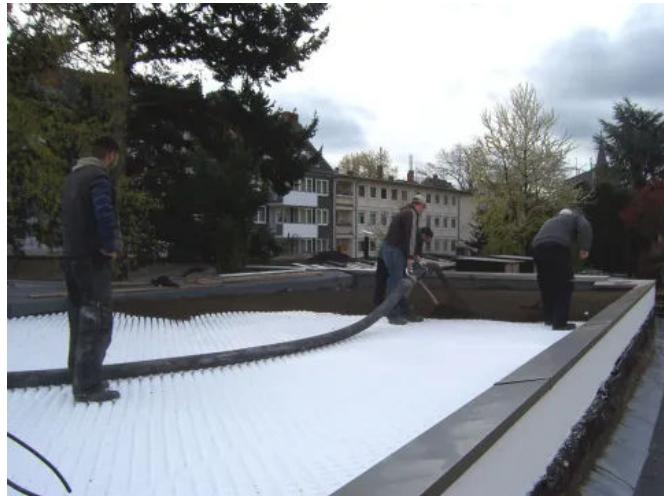
Ist selbst der „Sedumteppich“ als Standardausführung zu schwer, dann ist Aufbau mit Floraset® FS 75 zuverwenden. Die Substratschicht ist dort nicht einheitlich dick ausgebildet wird, sondern die Mulden zwischen den einzelnen Noppen der Elemente fungieren als „Pflanzköpfen“. Obwohl rasterförmig verteilt, bilden die Sedumpflanzen einen geschlossen erscheinenden Bestand, der im Laufe der Zeit durch Moose ergänzt wird.
