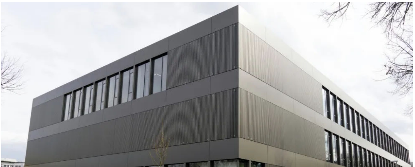
etalbond® am Zentrum für angewandte Quantentechnologie, Stuttgart
