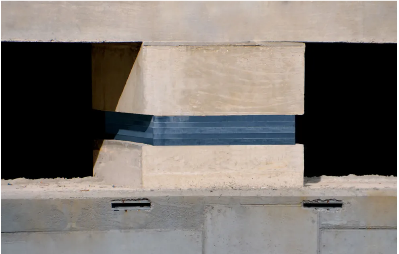
Anwendungsbeispiel - Punktförmige Gebäudelagerung
