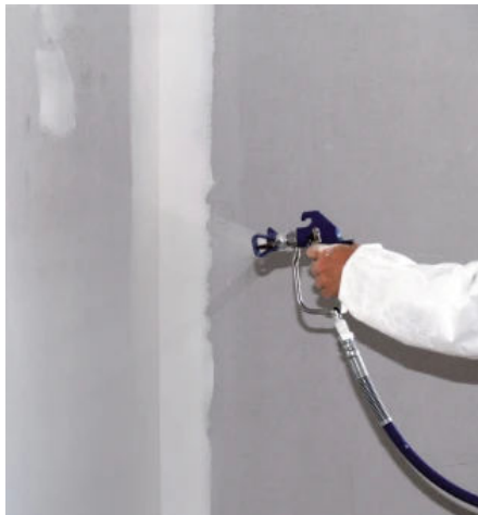
Der effiziente Kleisterauftrag erfolgt mit dem Airless-Gerät.
