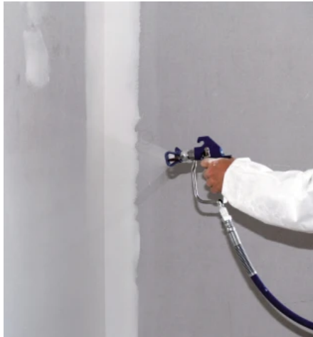
Der effiziente Kleisterauftrag erfolgt mit dem Airless-Gerät.
