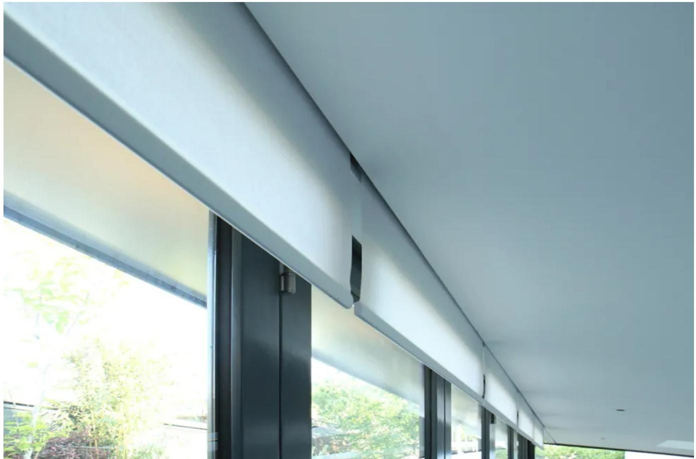
Bereits in der Planungsphase dient die S-Box Einbaukassette als Verbindung zwischen Fassade (Fenster) und Trockenbau. Die verschiedenen Kassetten in den Größen 100 x 100 mm und 130 x 130 mm ermöglichen so eine Direktmontage.
