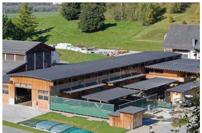
Wenn bei Sanierungen bestehende Dachaufbauten erhalten und überdeckt werden, spart das Abbruchkosten.
