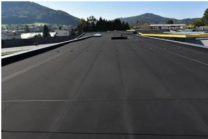
Die vlieskaschierten COVERiT NovoProof® DA-K Bahnen sind auf Leichtdächern verlegbar.
