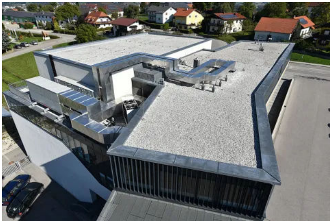
COVERiT NovoProof® Flachdachabdichtung mit Windsogsicherung durch vollflächige Kiesauflast
