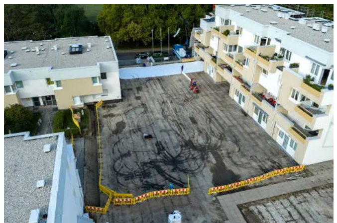
Die Dickvlieskaschierung der COVERiT NovoProof® DA-S Bahn erlaubt eine Verlegung auf bestehenden Dachschichten.
