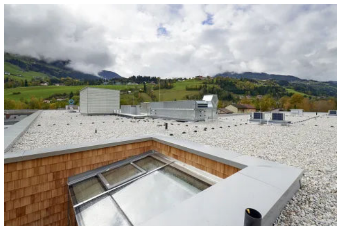
COVERiT NovoProof® Großplanen, im Stück bis 1.500 m², lose mit Auflast verlegt
