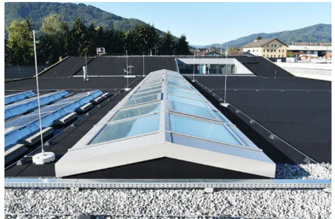
COVERiT NovoProof® als wirtschaftliche Abdichtungslösung für Dächer mit vielen Anschlussstellen
