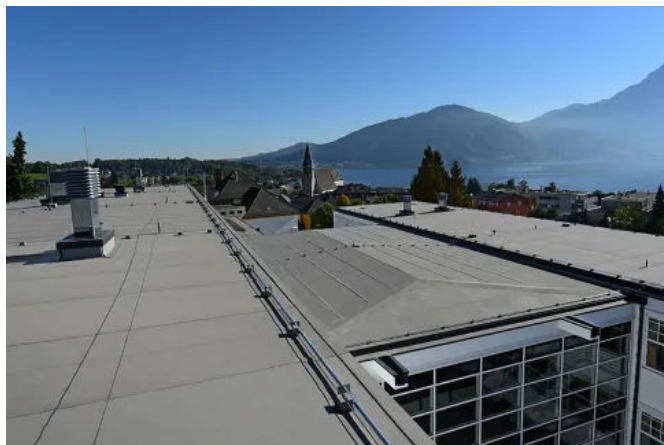
COVERiT NovoProof® DA-FG mit Glasgewebekaschierung eignet sich für EPS-gedämmte Dächer mit Brandschutzanforderung.
