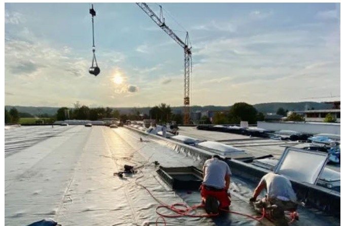
Durch die Vorfertigung im Werk reduzieren sich Aufwand und Fehlerquellen auf der Baustelle.
