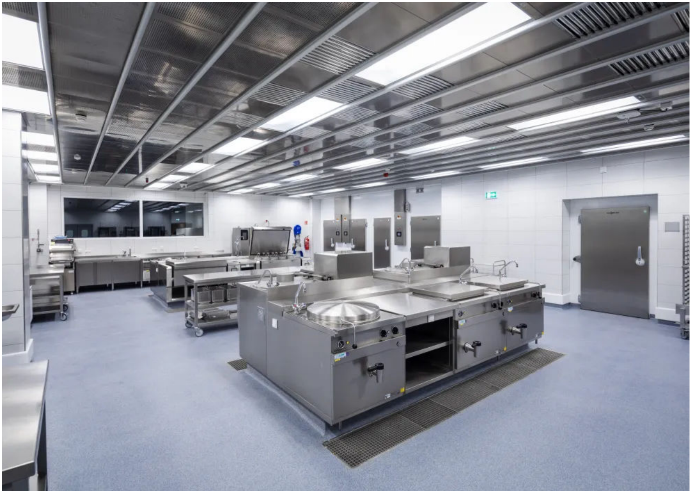
Bodenrinnen in einer Großküche (© Jan Meier, Bremen)
