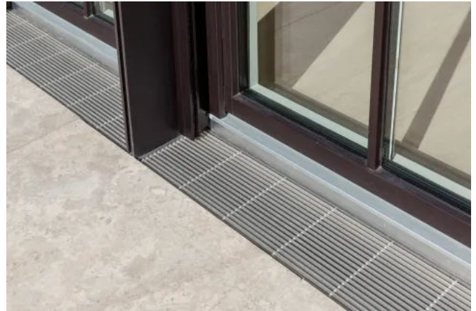
Fassadenrinne mit Linearrost, Längsstab 3 mm
