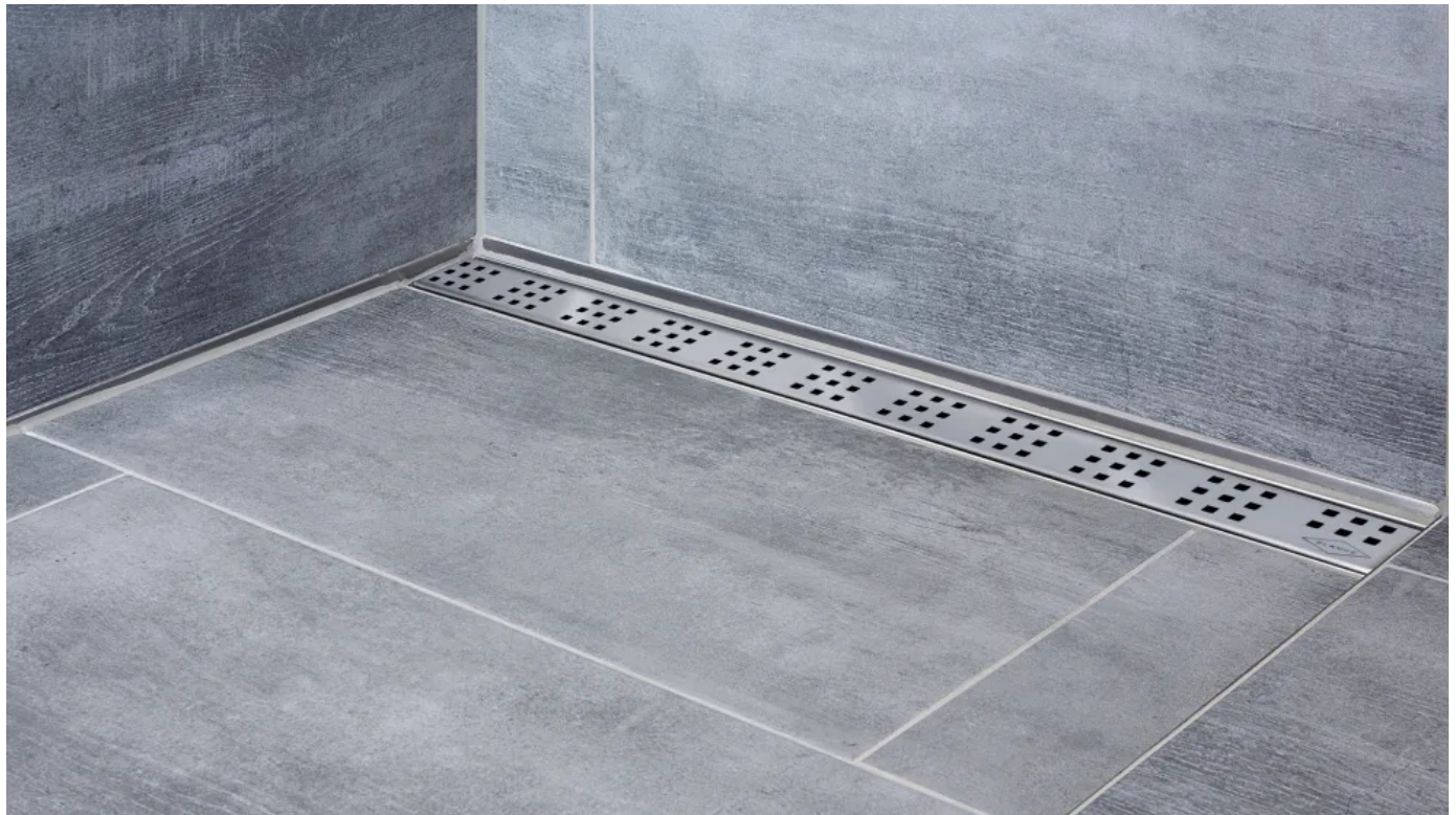
BLANKE DIBA-LINE SL eingebaut
