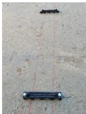
Kunststofffuß auf Sauberkeitsschicht aufschrauben.
