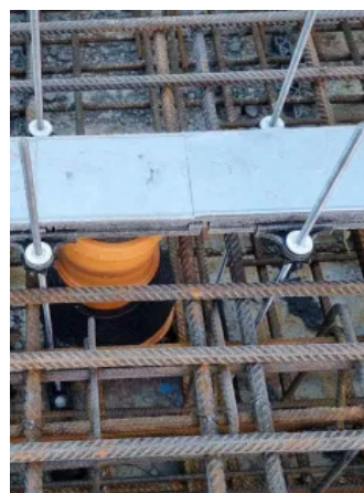
Rinne montieren und mit Montageabdeckblech schützen.
