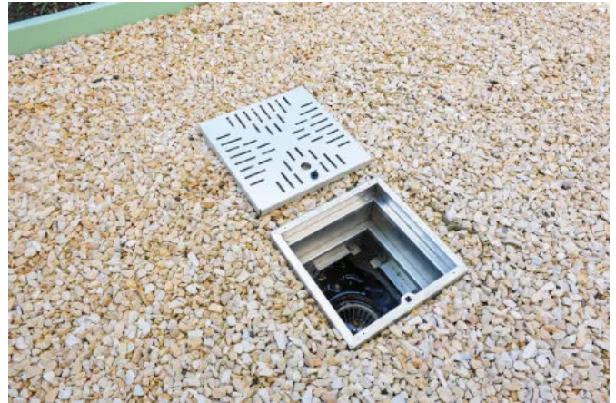
Mit den revisionierbaren Kontrollschächten sowie den eingesetzten Stichkanälen ist die Entwässerung der äußeren sowie mittleren Bereiche der Höfe sichergestellt.
