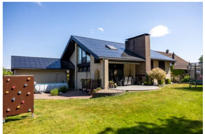
Bauvorhaben Grobe ©Ennogie
