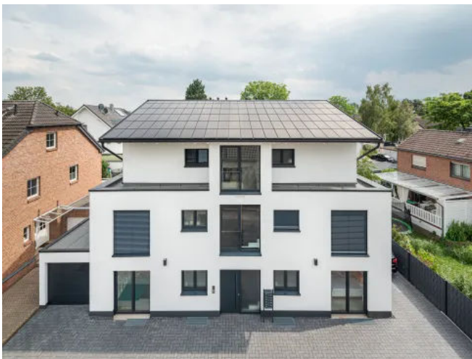
Bauvorhaben Köln ©Thomas Bush
