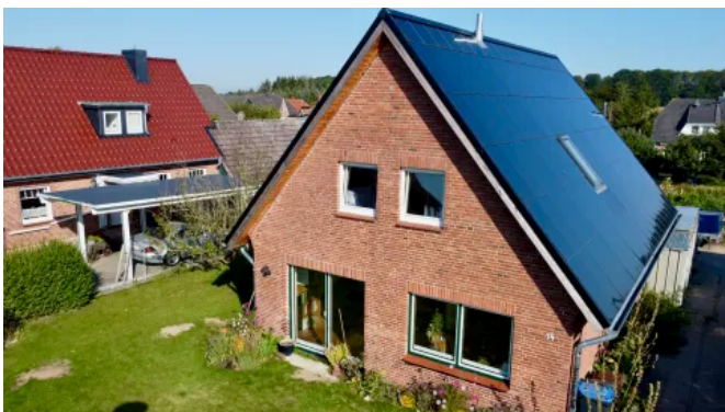
Bauvorhaben Keller ©Ennogie
