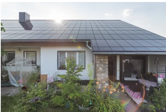
Bauvorhaben Magdeburg ©Ennogie
