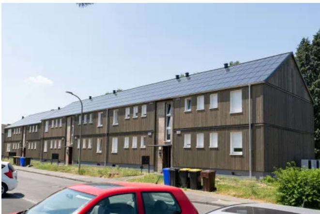
Bauvorhaben B und O ©Ennogie
