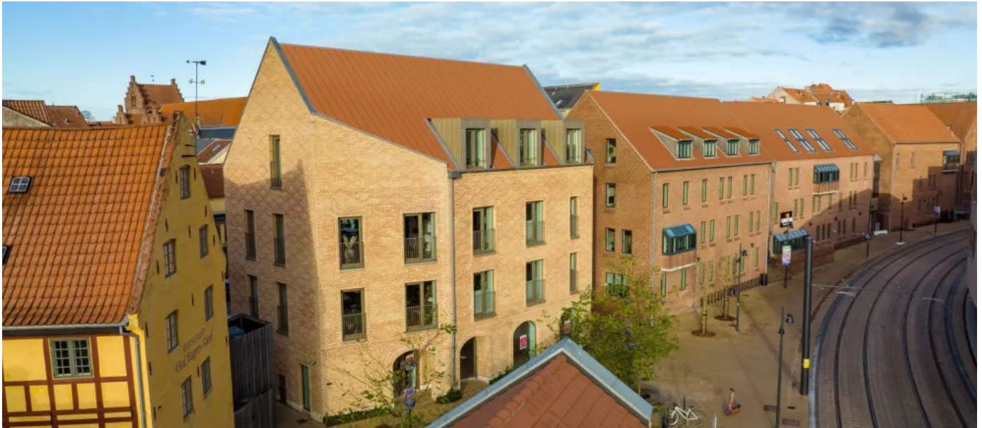
Bauvorhaben Odense ©Ennogie
