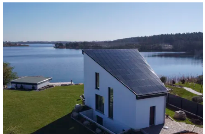
Bauvorhaben in Niegripp ©Ennogie
