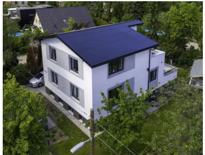
Bauvorhaben Riedl Berlin ©Ennogie
