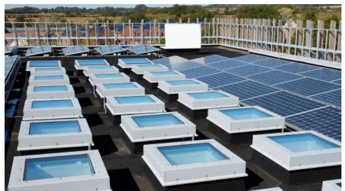
LAMILUX Flachdach Fenster FE Passivhaus Eco Business Centre in Bicester, Großbritannien
