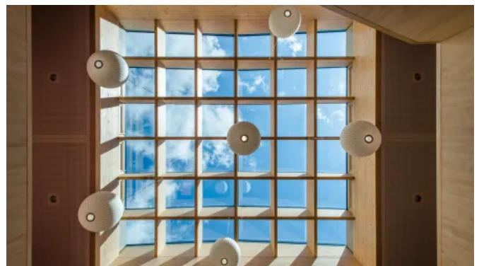
LAMILUX Glasdach PR60 Passivhaus Kita in Frankfurt-Harheim
