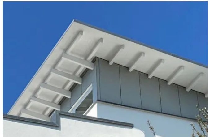
Dachüberstand mit „vita grundiert“ im geschützten Aussenbereich
